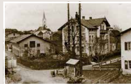
Trafostation an der Ecke Miesbacher – Frühlingsstraße
