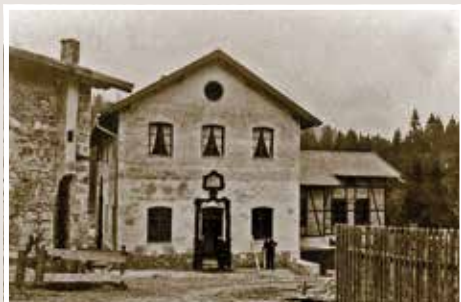
Eröffnung der Zentrale des Holzkirchner E-Werks 1894
