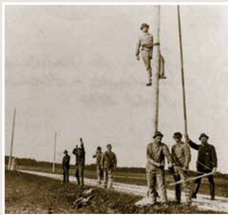
Spannen der Freileitungskabel bei Marschall
