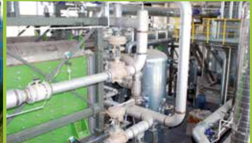
Geothermie Holzkirchen: Kraftwerksbau startet im Herbst
